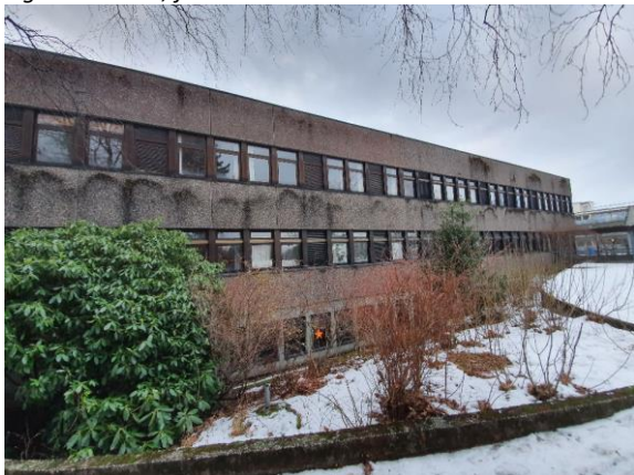
Figur 9 Blokk 2, fasade øst
