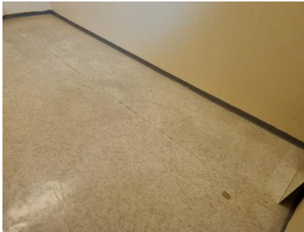
Figur 24 Prøve P5, gulvbelegg m/ gult lim, i rom 132 plan 1 Blokk 1. Det ble ikke påvist asbest i prøven
