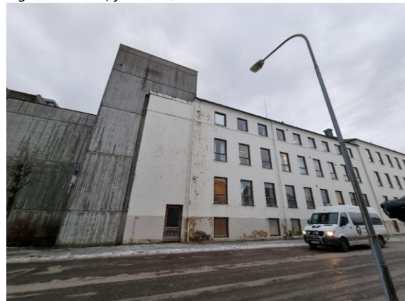
Figur 10 Blokk 1 og 2, fasade nord
