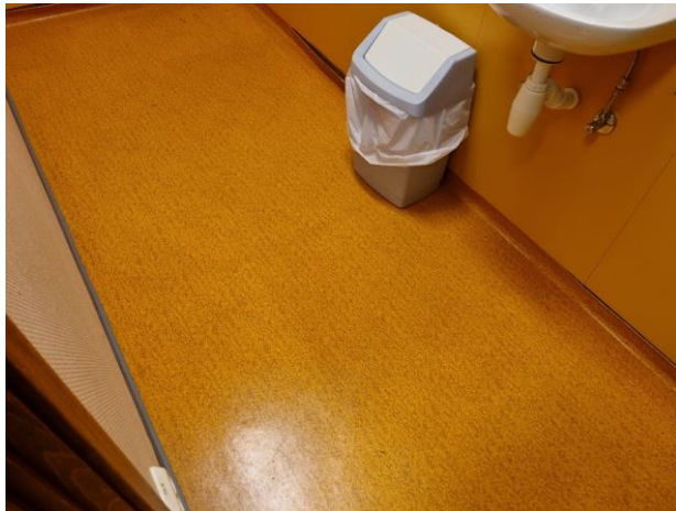
Figur 27 Prøve P9, oransje linoleum m/ lim, i rom 215A plan 2 Blokk 2. Det ble ikke påvist asbest i prøven.
