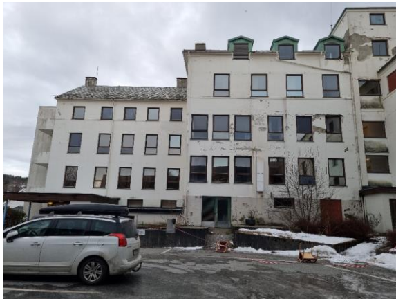
Figur 5 Blokk 1, fasade øst
