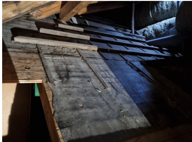
Figur 20 Prøve (P21) tatt av takpapp i Blokk 1, det ble ikke påvist asbest i prøven.
