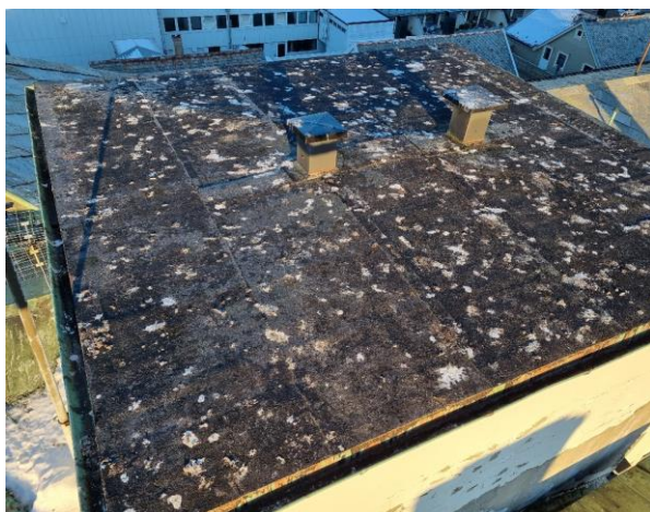
Figur 19 Taket av Blokk 1 teknet med takpapp (P1), det ble ikke påvist asbest i prøven.
