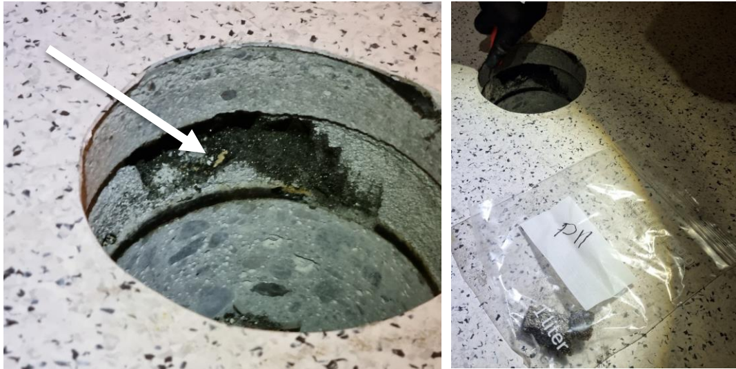
Figur 64 Isolasjonslag mellom påstøp og betong (P11).
