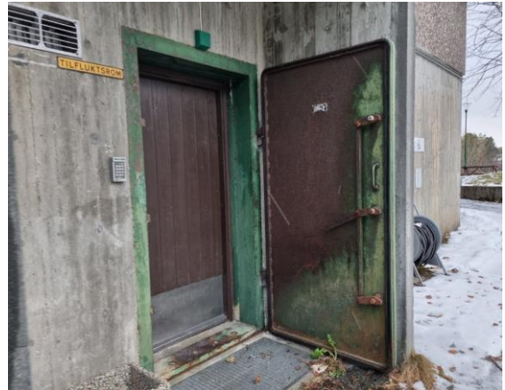
Figur 35 Branndører fra 1974 ved tilfluktsrom. Branndørene antas å inneholde asbest.
