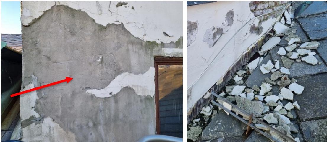
Figur 45 Prøve av puss (P3) på fasaden viser ikke verdier av PCB eller tungmetaller over grensen for farlig avfall
