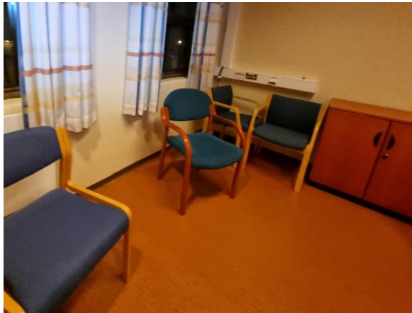
Figur 30 Prøve P13, rødbrunt gulvbelegg, i rom 147 plan 1 Blokk 1. Det ble ikke påvist asbest i prøven.
