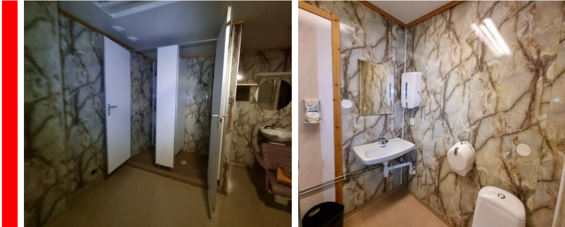
Figur 73 Marmorimiterte baderomspanel på behandlingsrom og bad i Blokk 2
