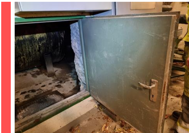
Figur 36 Branndør i fyrrom og heisdør i blokk 1. Dørene antas å inneholde asbest.
