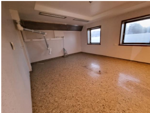
Figur 31 Prøve P15, marmor gulvbelegg m/ svart lim, i rom 337 plan 3 Blokk 1. Det ble ikke påvist asbest i prøven.
