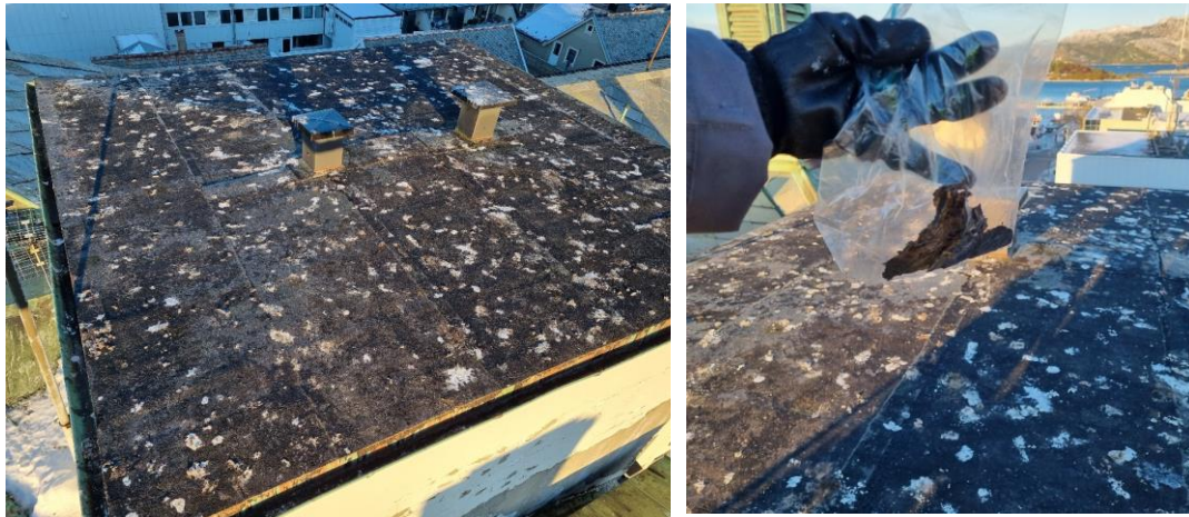
Figur 50 Taket av Blokk 1 tekket med takbelegg (P1), det ble ikke påvist PAH verdier over grenseverdien for farlig avfall
