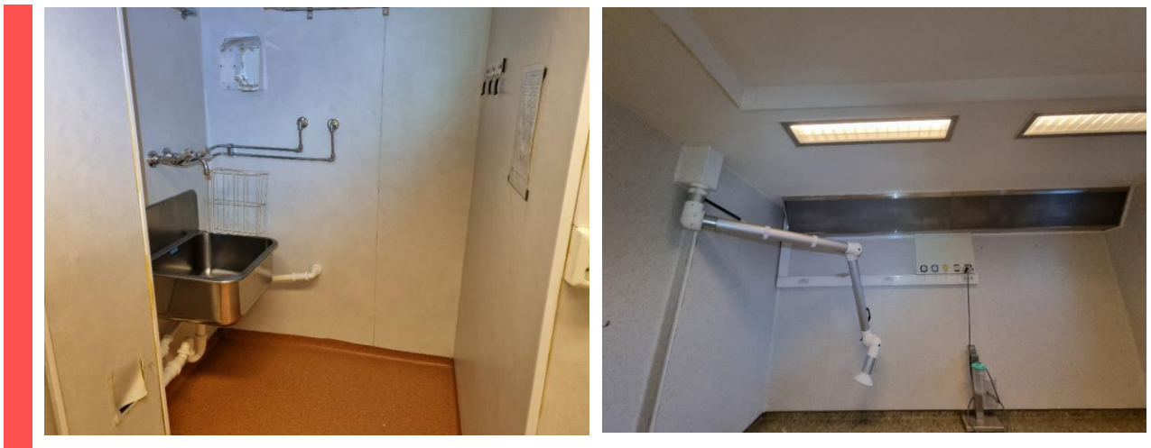
Figur 59 Eksempel på vinyltapet på rom 331 og rom 337 i 3. etg. Blokk 1
