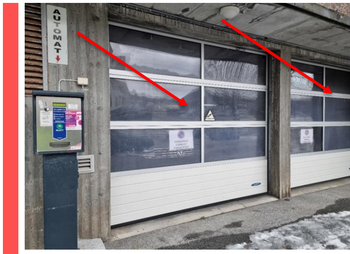
Figur 65 Leddporter i garasje, underetasje Blokk 2.
