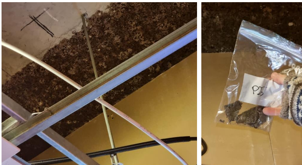
Figur 63 Korkisolasjon i himlingen i underetasjen Blokk 2 (P19).
