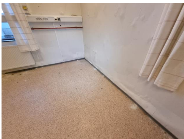
Figur 32 Prøve P16, lys rosa m/ svart lim, i rom 354 plan 3 Blokk 1. Det ble ikke påvist asbest i prøven.
