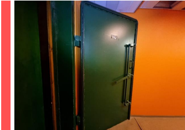
Figur 35 Branndører fra 1974 ved tilfluktsrom. Branndørene antas å inneholde asbest.
