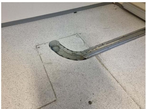
Figur 29 Prøve P10, hvit prikkete gulvbelegg m/ lim, rom 111 plan 1 Blokk 2. Det ble ikke påvist asbest i prøven.
