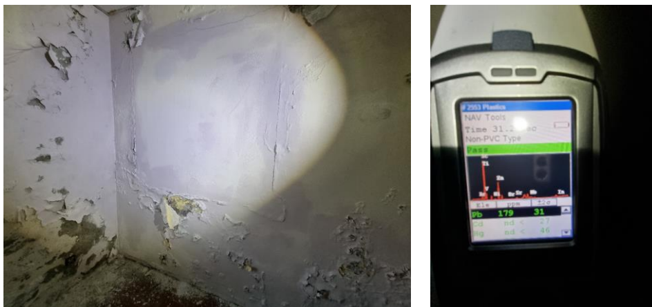
Figur 60 XRF-registrering for innvendig maling på yttervegg.
