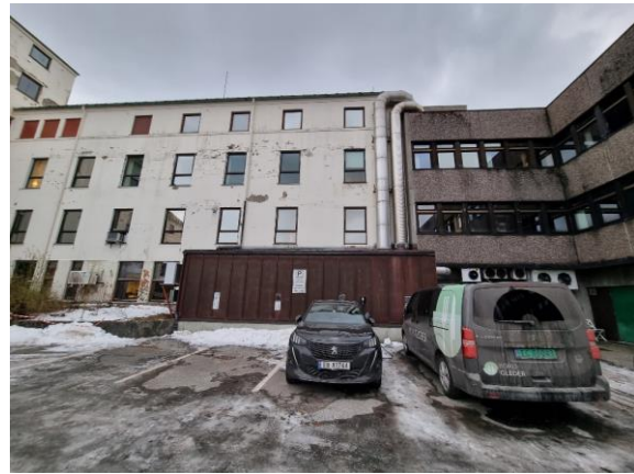
Figur 6 Blokk 1 og 2, fasade sør
