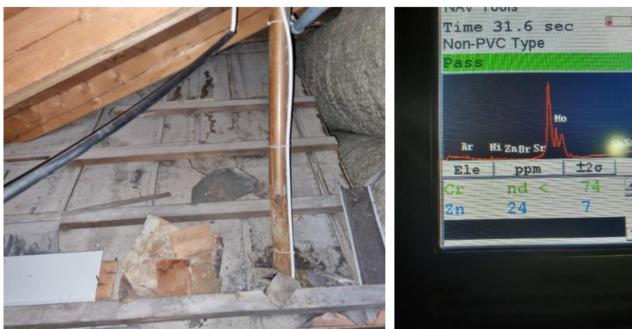
Figur 72 Trevirke i takkonstruksjon undersøkes med XRF-pistol. Det ble ikke funnet impregnering av trevirke.
