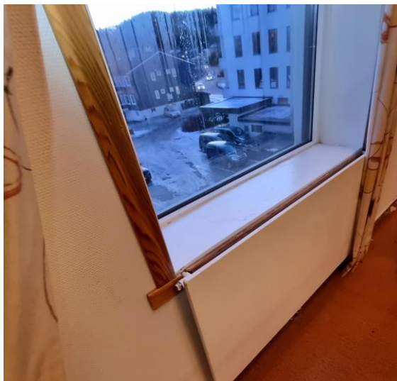
Figur 49 Nyere isolerglassruter på sørfasade.
