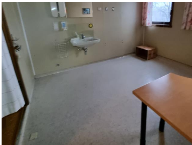
Figur 28 Prøve P9, hvitt gulvbelegg m/ lim, i rom 229 plan 2 Blokk 2. Det ble ikke påvist asbest i prøven.
